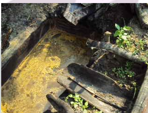
CUVE DE COLLECTE D'HUILE INSALUBRE ET POLLUTION DES COURS D'EAU
